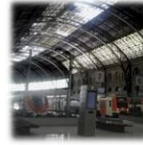
Estación de Francia
